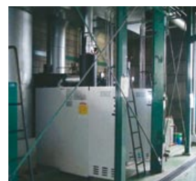
ボイラー室の耐震補強
